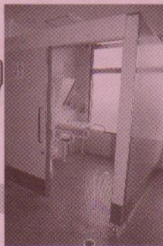
3階に設置した障がい者用トイレ
